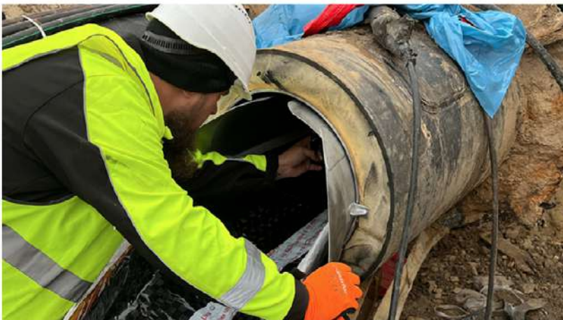
Quabus ist unter anderem auf grabenlose Leitungssanierung, Erdbau und Außengestaltung, spezialisiert.
